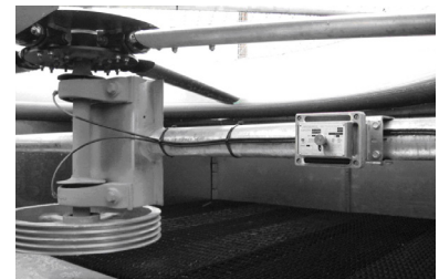
Slika 2: Standardna instalacija modela 5550 na nosaču ventilatora rashladnog tornja.
