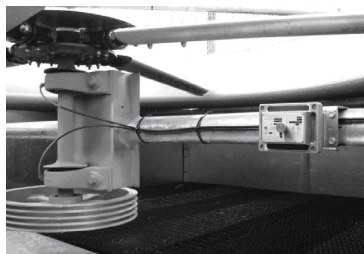
Рис. 2. Стандартная установка 5550 на поддерживающей стойке вентилятора градирни.
